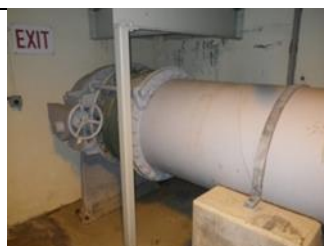
Biotower effluent pipe
