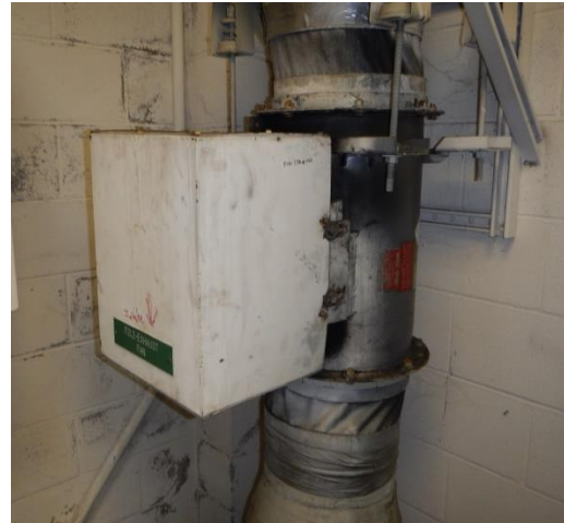
Existing Exhaust Fan
