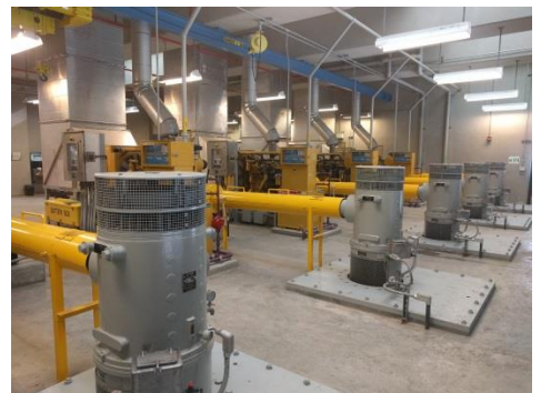
Effluent Pumps
