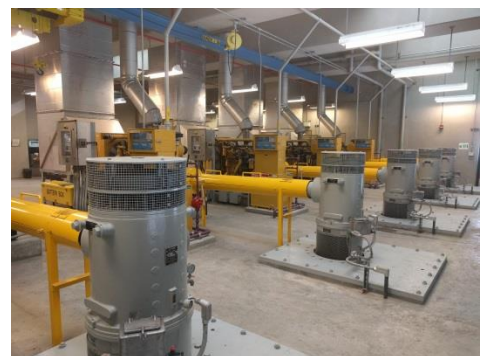
Effluent Pumps
