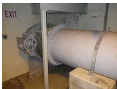
Biotower effluent pipe
