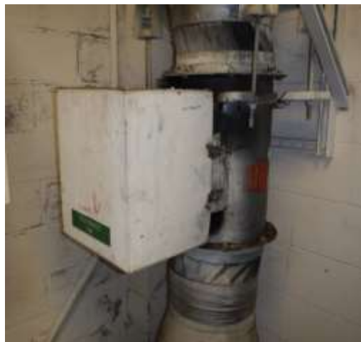
Existing Exhaust Fan
