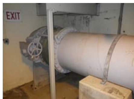
Biotower effluent pipe
