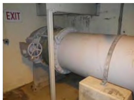
Biotower effluent pipe
